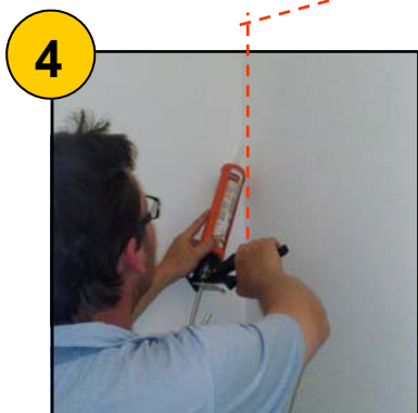
4 Pose d'un silicone au pourtour du panneau
