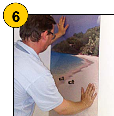
6 Pose du panneau, appliquer une pression sur la totalité de la surface durant la prise de la colle
